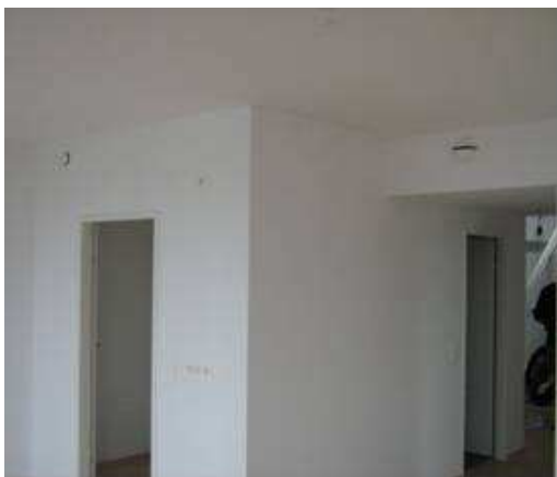
Abbildung 53: Zuluftöffnungen
