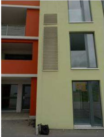
Abbildung 56: Außenluftansaugung
