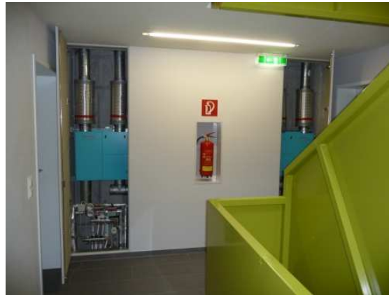
Abbildung 4: Dezentrale Einheiten
