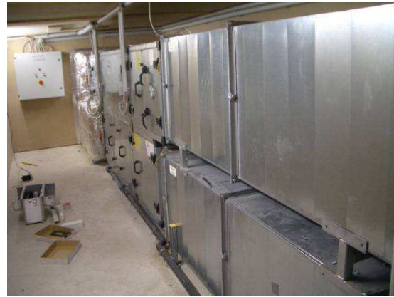
Abbildung 13: KWL-Anlage (Dachbereich)
