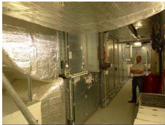
Abbildung 55: Zentralgerät
