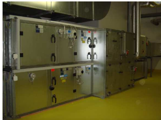
Abbildung 21: Lüftungszentrale
