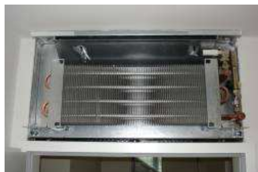
Abbildung 15: Konvektor ohne Verkleidung
