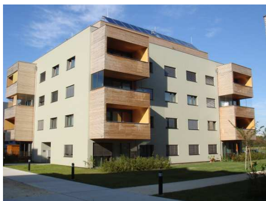
Abbildung 28: Anlage Fritz Kandlgasse
