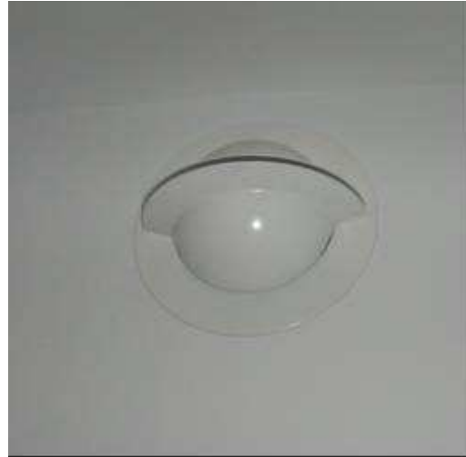
Abbildung 50: Zuluftdurchlass
