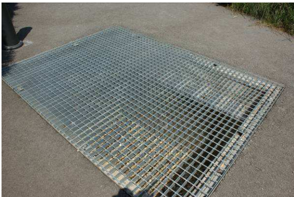
Abbildung 26: Fortluftöffnung
