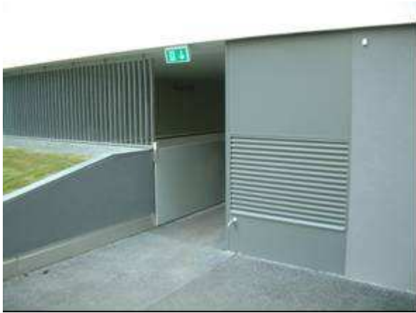
Abbildung 42: Außenluftansaugung
